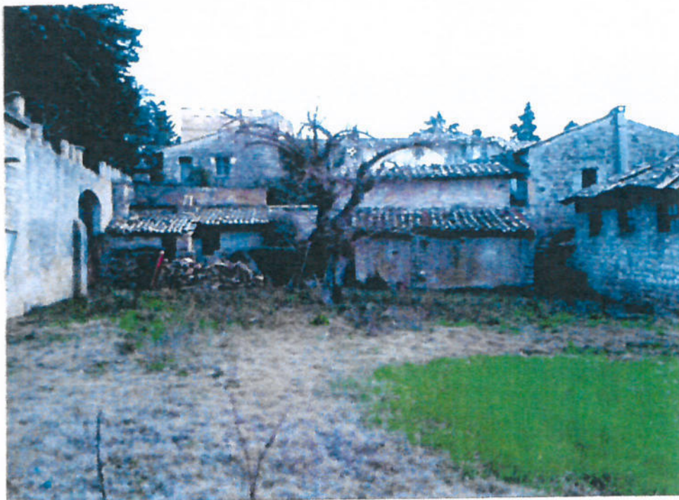
Foto n. 4 - Edificio 78-1/c e superfetazioni
