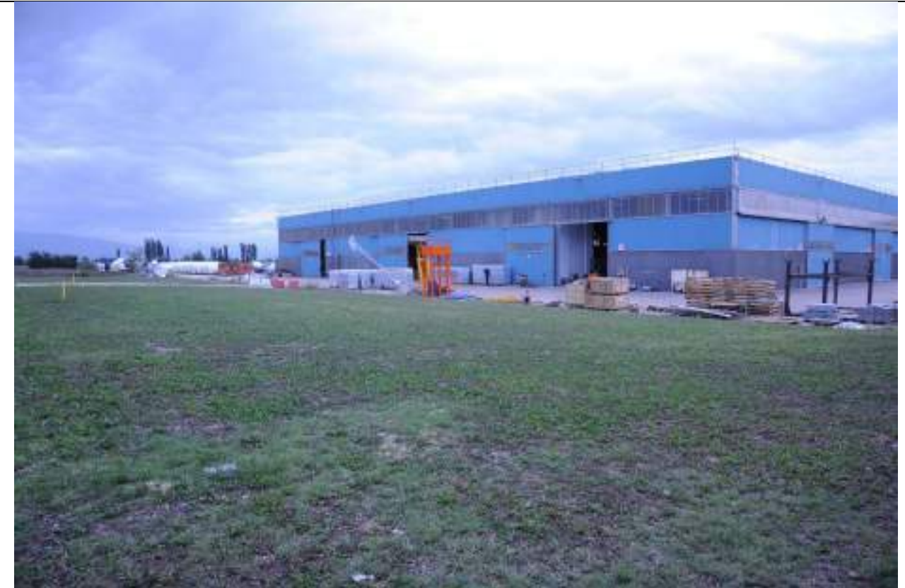
P14 – Foto del lato est dell'edificio A
