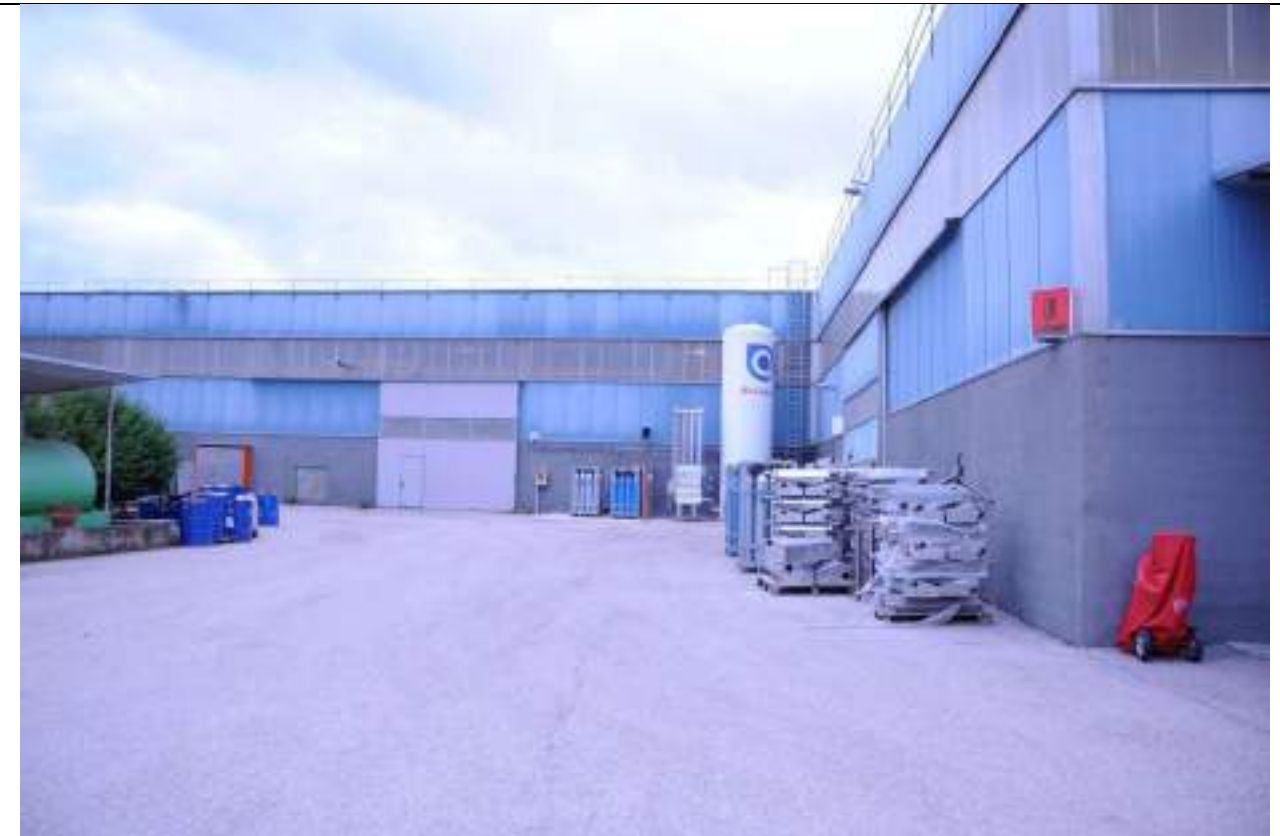
P9 – Foto del lato sud dell'opificio A
