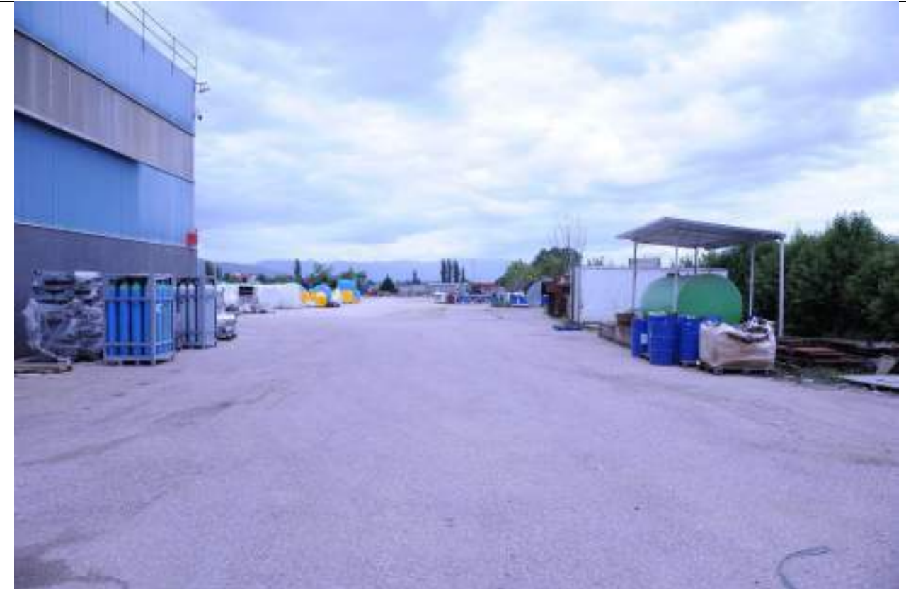
P9 – Foto dal lato sud dell'opificio A verso l'area attualmente destinata allo stoccaggio ove è previsto l'ampliamento dell'opificio n. 1
