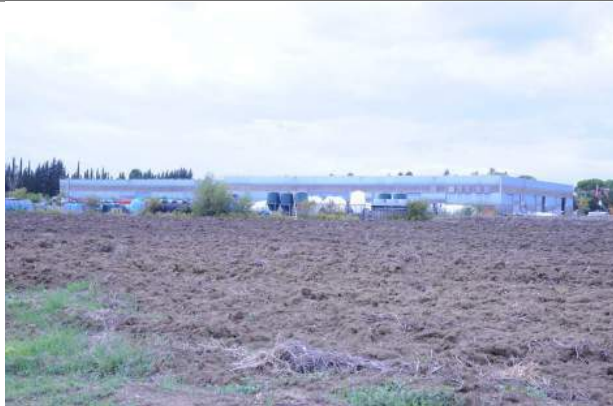
P5 – Foto da via Fonte Citerna verso l’edificio A
