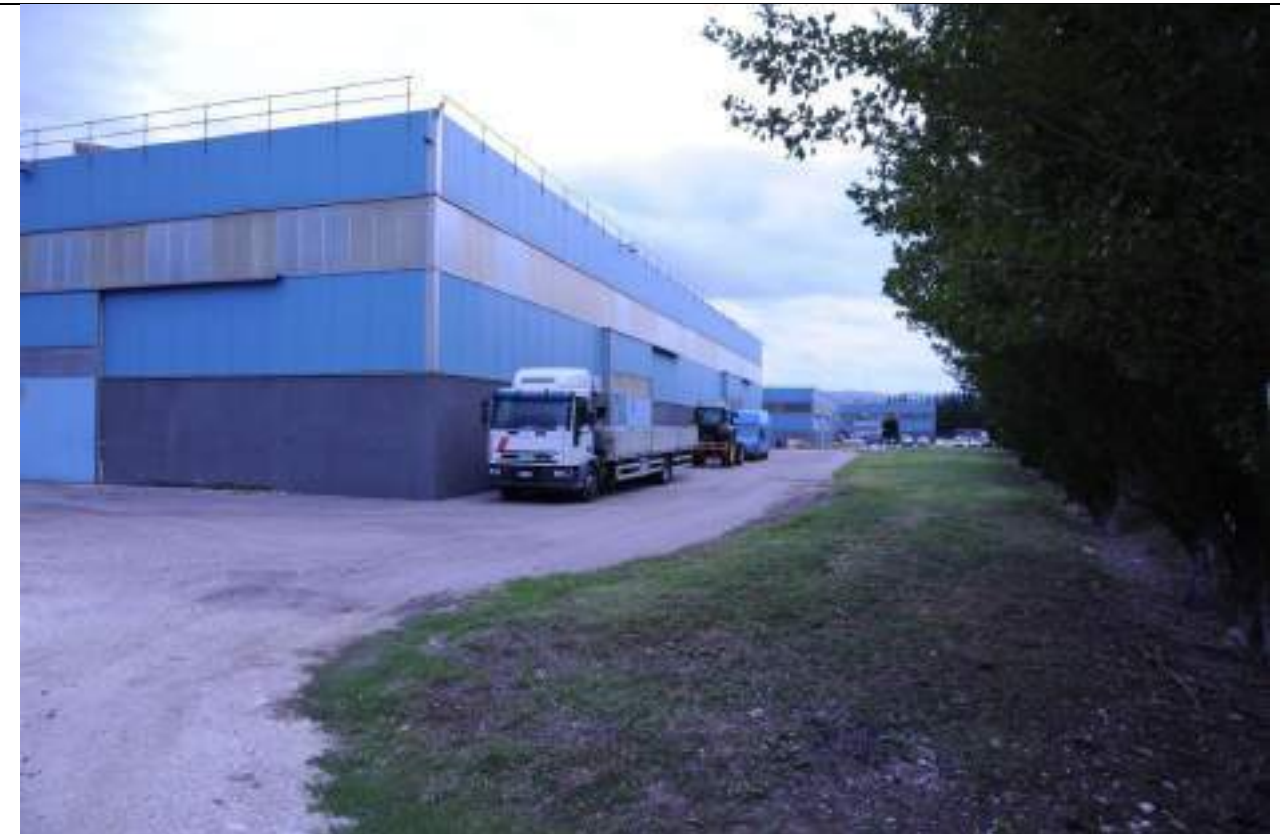
P13 – Foto panoramica del lato nord della proprietà in primo piano lo spigolo nord-est dell'edificio B
