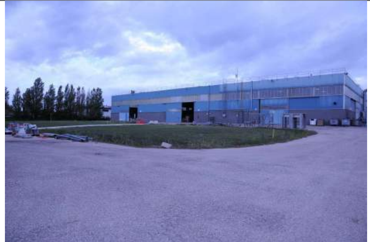
P11 – Foto edificio dell'edificio B
