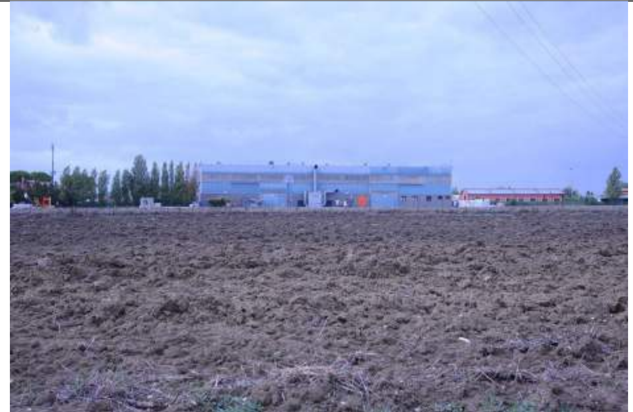
P5 – Foto panoramica da via Fonte Citerna verso l’edificio B
