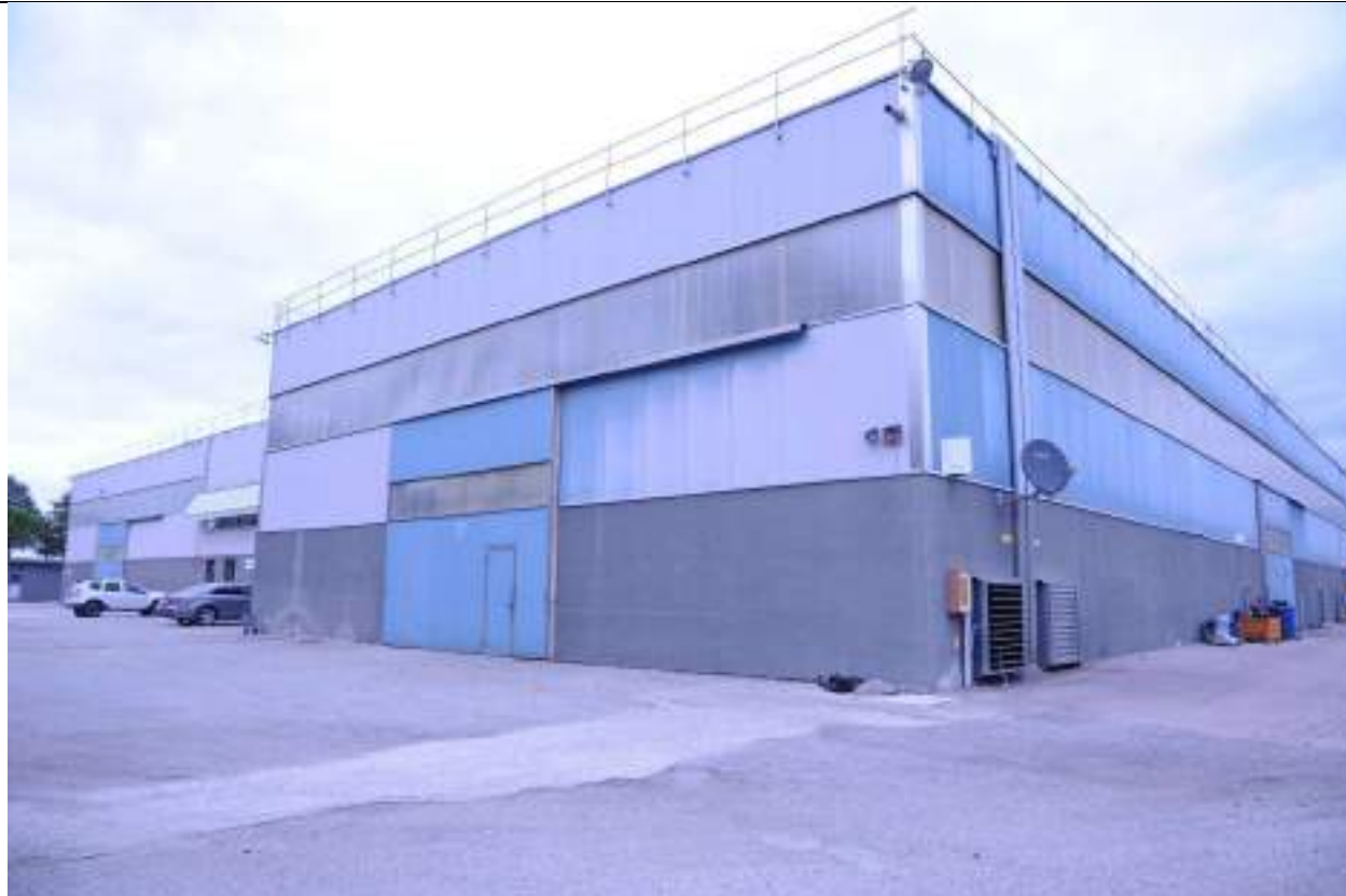
P8 – Foto dello spigolo sud-ovest dell'edificio A
