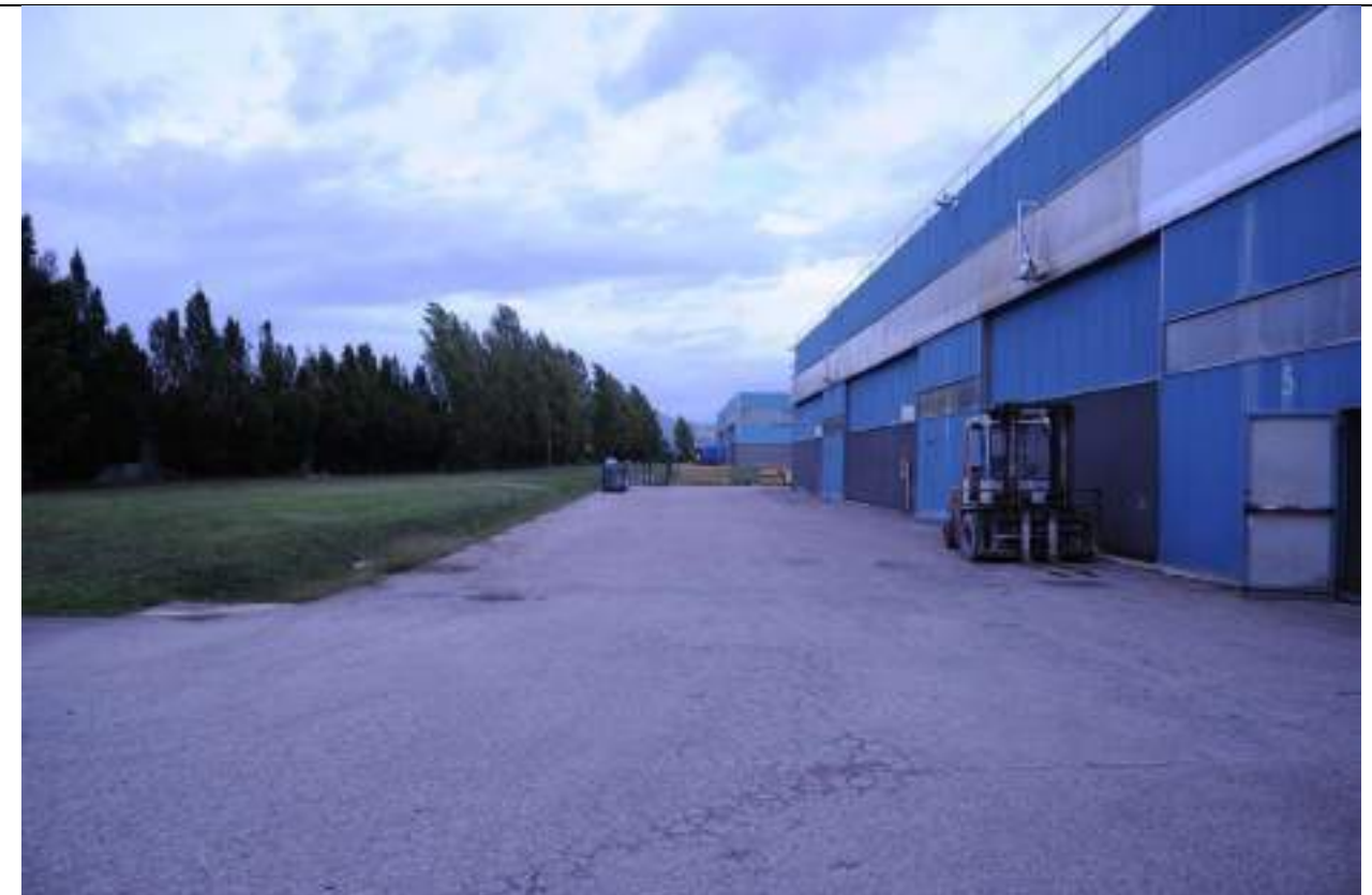
P15 – Foto panoramica dal lato est dell'edificio A verso Assisi
