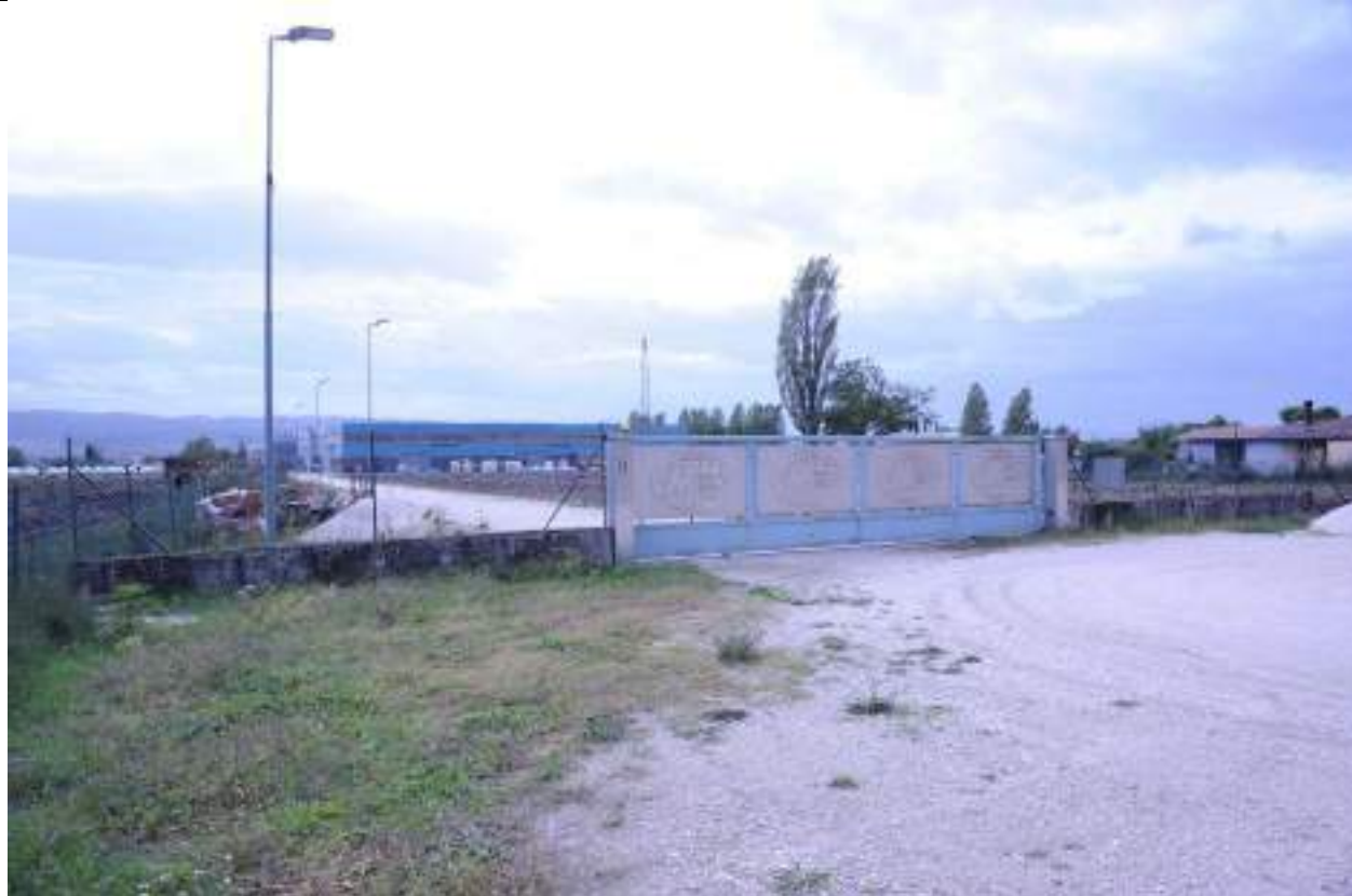
P4 – Foto da via del Martorello in primo piano ingresso secondario della Mial sullo sfondo l’edificio B
