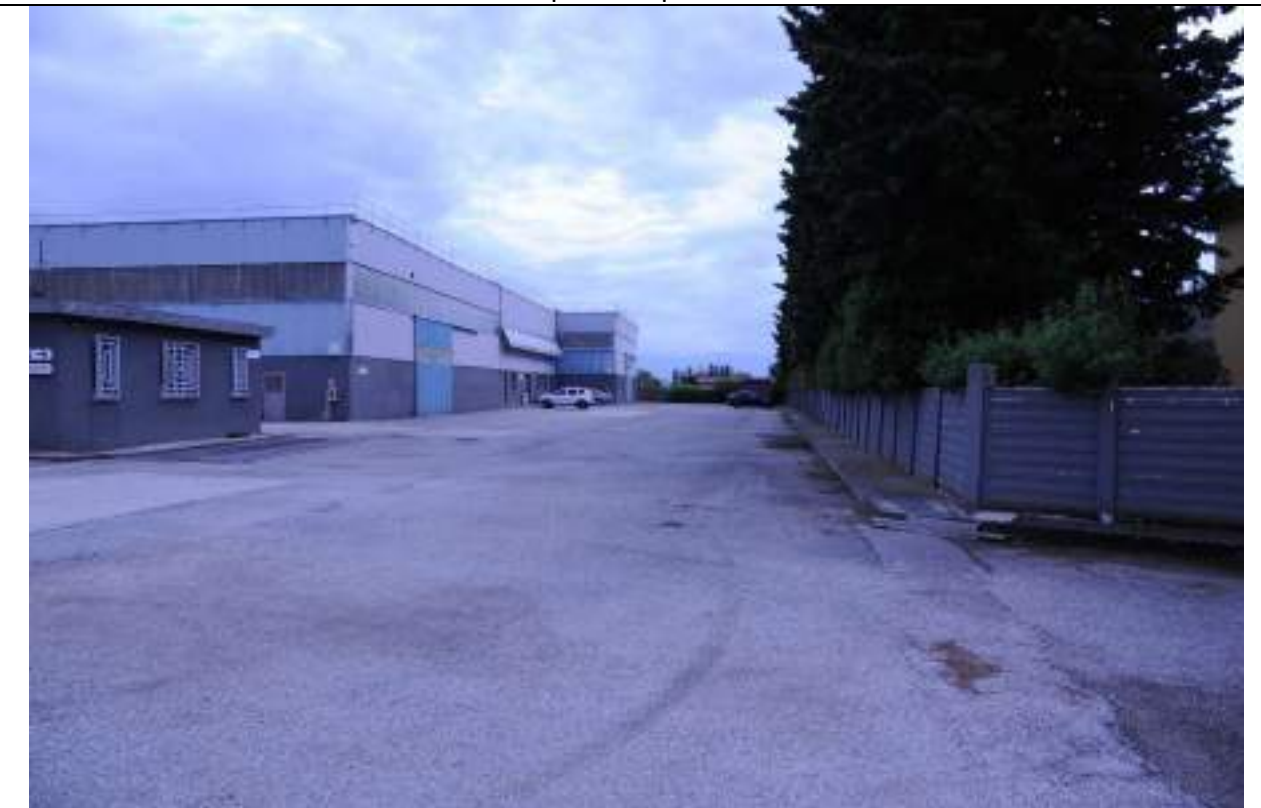
P7 – Foto panoramica dello spigolo sud – ovest dove verrà ampliato con l’edificio degli uffici
