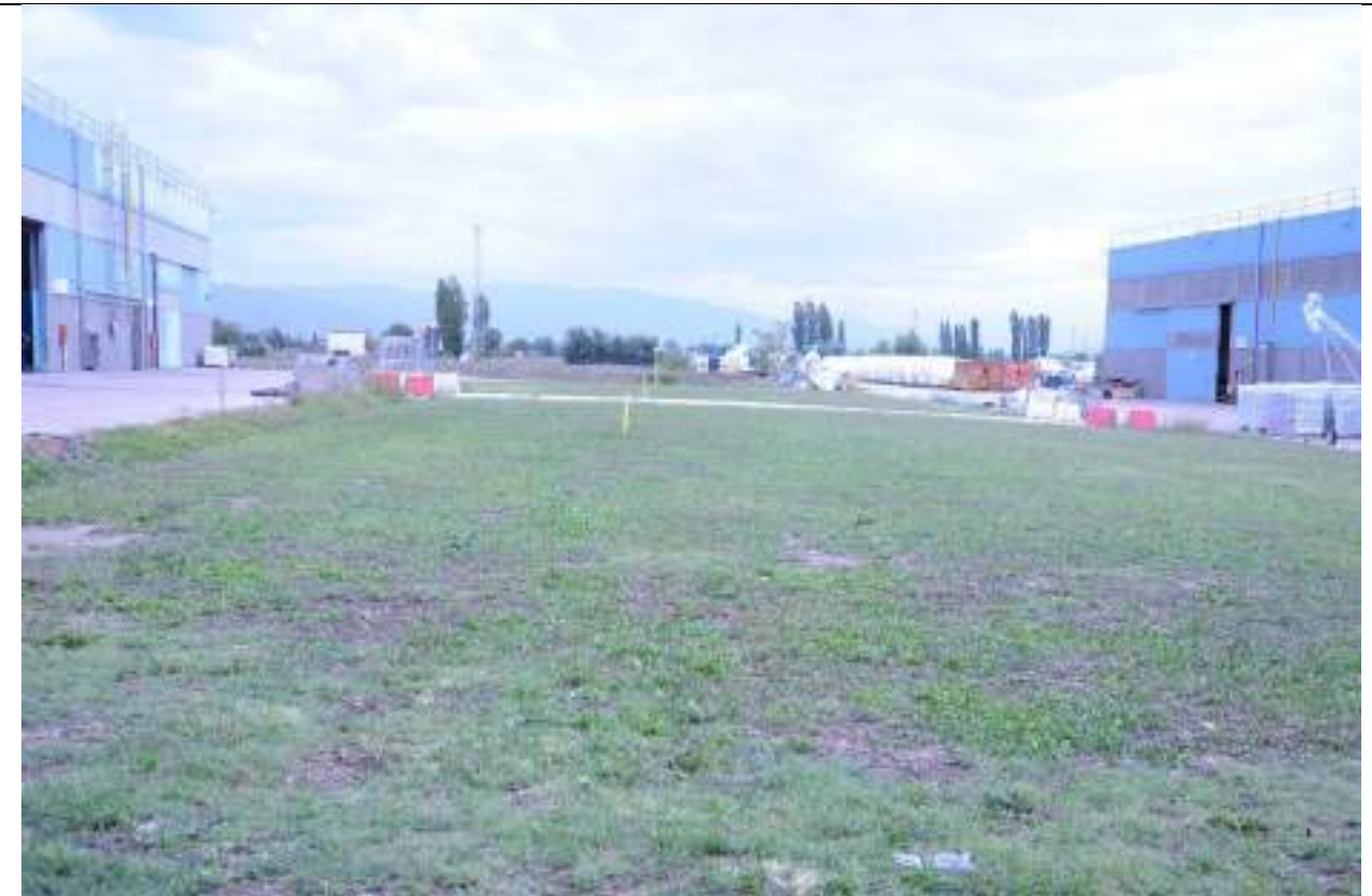
P14 – Foto nell'area verde tra l'edificio A e B che è attraversato dal metanodotto
