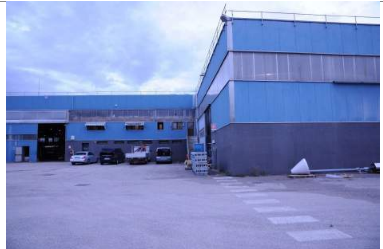
P15 – Foto del lato nord dell'edificio A
