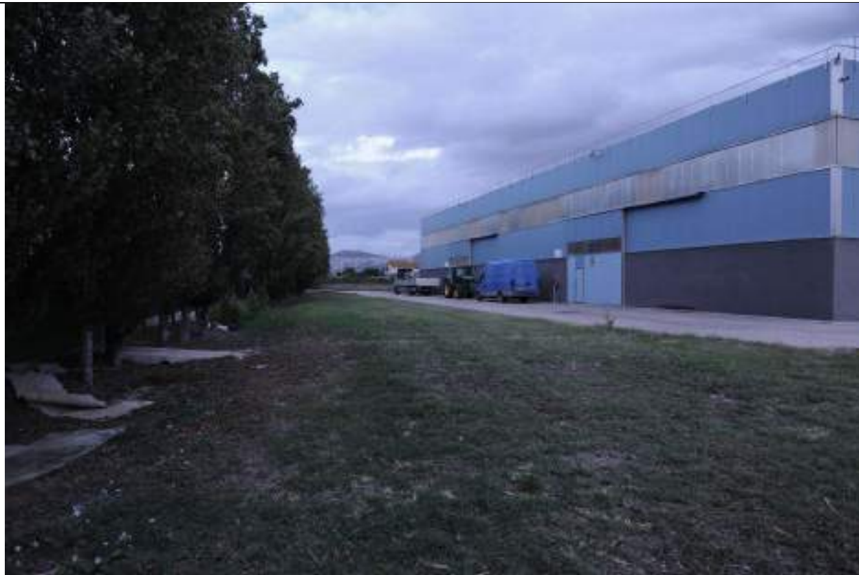
P14– Foto panoramica dal lato nord dell'edificio B verso Assisi
