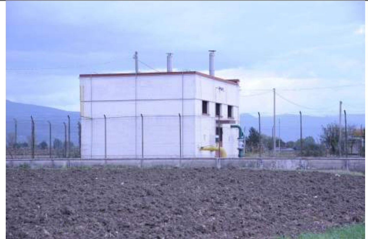
P5 – Foto da via Fonte Citerna della cabina del metano
