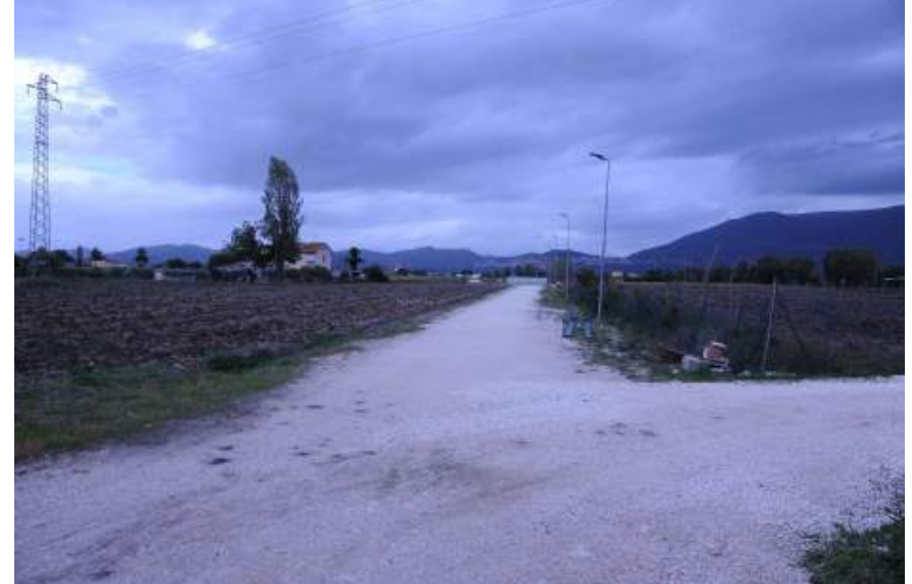
P12 – Foto panoramica dell'ingresso secondario della Mial sullo sfondo Assisi
