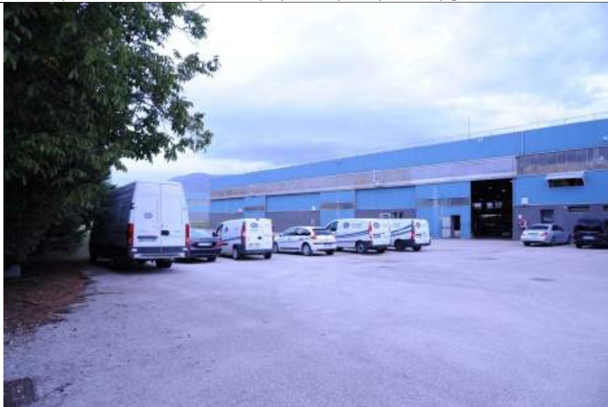
P15 – Foto del lato nord dell'edificio A
