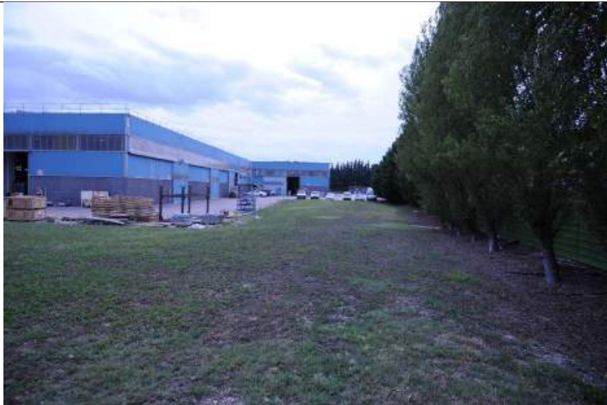
P14– Foto panoramica del lato nord della proprietà in primo piano lo spigolo nord-est dell'edificio A
