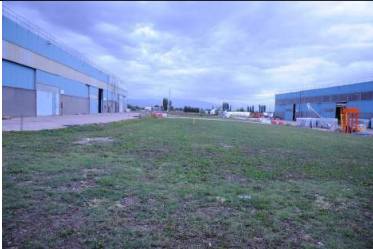
P14 – Foto panoramica nell'area verde tra l'edificio A e B che è attraversato dal metanodotto
