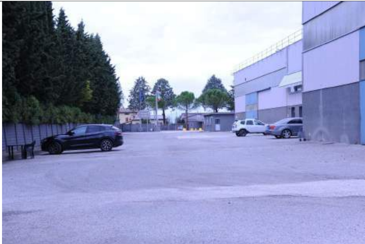
P8 – Foto del lato ovest dell'edificio A
