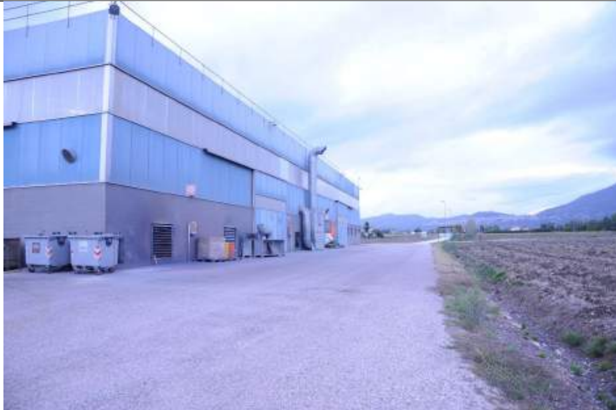
P9 – Foto panoramica dal lato sud est, a destra l'area in cui verrà realizzato l'edificio n.3 e sullo sfondo il centro storico di Assisi
