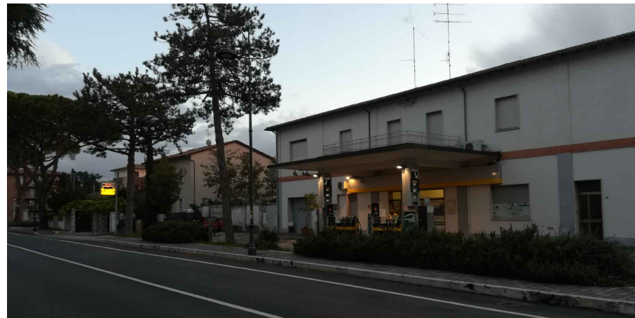
05_Vista da via Los Angeles
