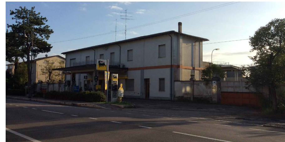
06_Vista da via Los Angeles
