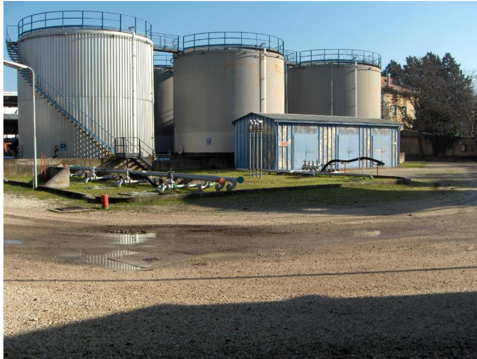
FOTO 5 Ripresa interna verso i silos e i manufatti di servizio (fotografia scattata nel periodo in cui l'attività era in esercizio)
