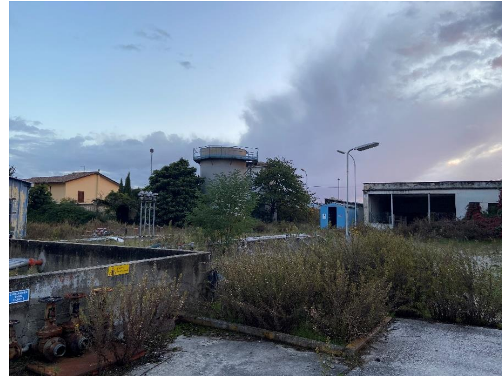
FOTO 6 Ripresa interna verso la via E. Toti, sul fondo si vedono gli edifici a confine e altri manufatti di servizio. In primo piano sono presenti manufatti di cemento in stato di degrado.
